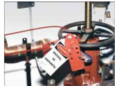
Рис.№3 Информационная бирка – неотъемлемая часть системы блокирования на производстве
