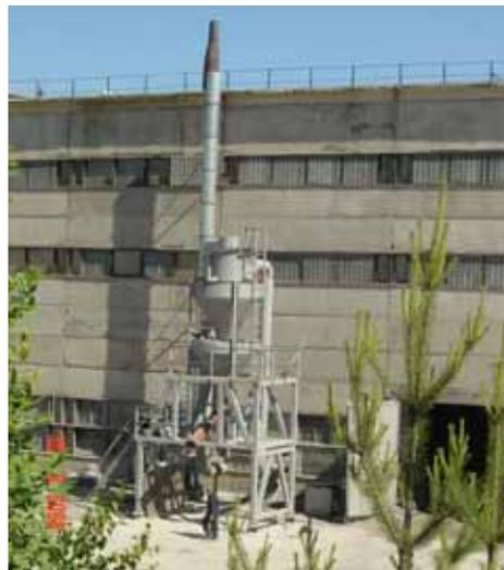
Рис.№ II. Модуль пылеулавливания на щебёночном производстве
