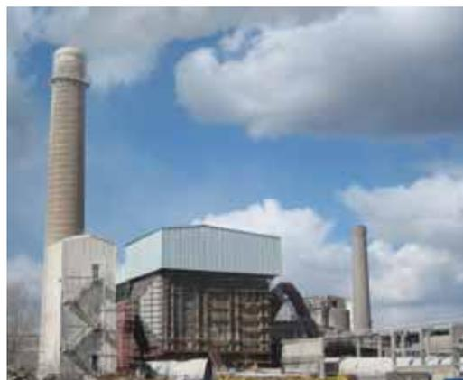
Общий вид на установку современных электрофильтров ЭГБ1М1
