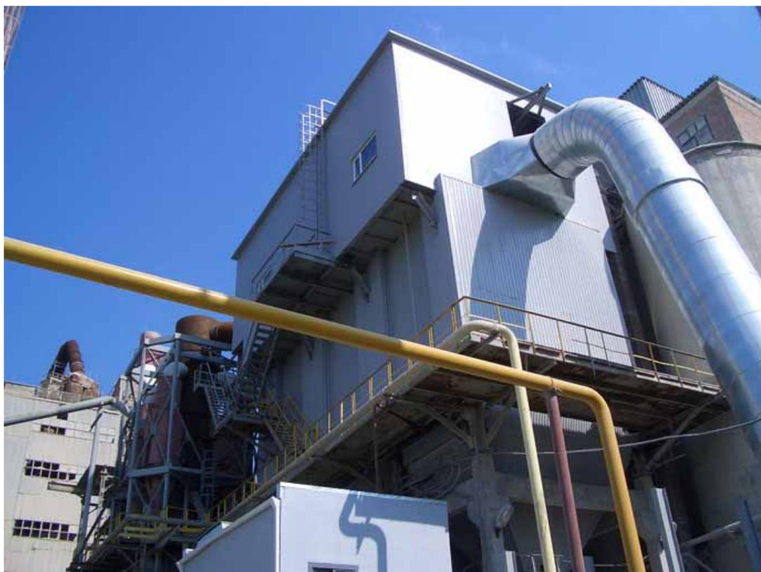
*Рис. 2. Рукавный фильтр ФРИ 3400 газоочистки вращающейся печи ООО «Атакайцемент»*
