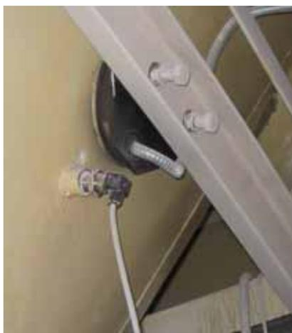
Рис. №2. Узел крепления индуктора к внешней поверхности очищаемого бункера
