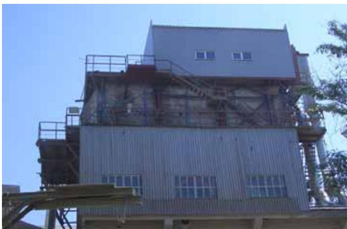
*Рис.4. Рукавный фильтр, смонтированный в корпусе электрофильтра УГ*
