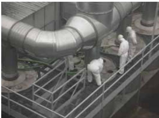
Рис. № 5 Замена активированного угля в адсорберах на фабрике по производству жевательной резинки ООО «Дирол Кэдбери» в г. Великий Новгород
