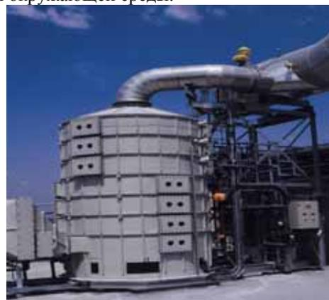
Рис. № 1 Установка БИОРЕАКТОР на предприятии фирмы VIP Ltd. (Бирмингем). Эффективность удаления формальдегида (▲) в зависимости от его концентрации на входе в биореактор (■); (●) – концентрация формальдегида на выходе из биореактора
