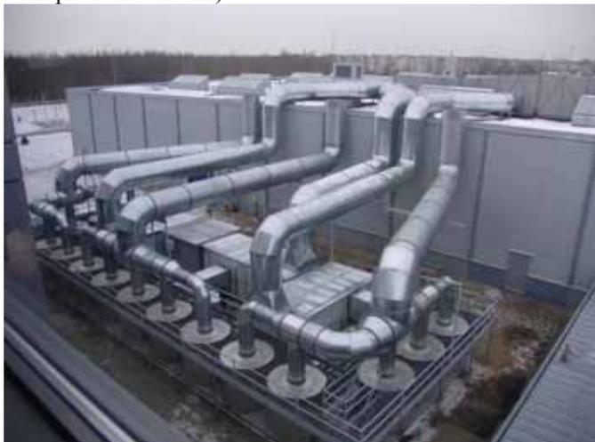
Рис. № 3 Система фильтрации воздушных выбросов (1 ступень) от смеси душистых веществ на фабрике по производству жевательной резинки ООО «Дирол Кэдбери» в г. Великий Новгород
