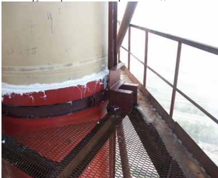
Фото № 2. Заделка раструбов химстойким герметиком.
