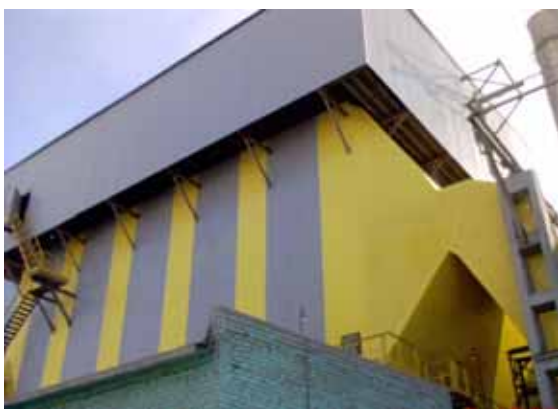
Современные электрофильтр «ФИНГО» на цементном заводе ОАО «Себряковцемент»
