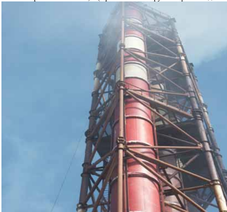
Фото № 1. Трёхствольная труба из фаолита в смонтированном виде.
