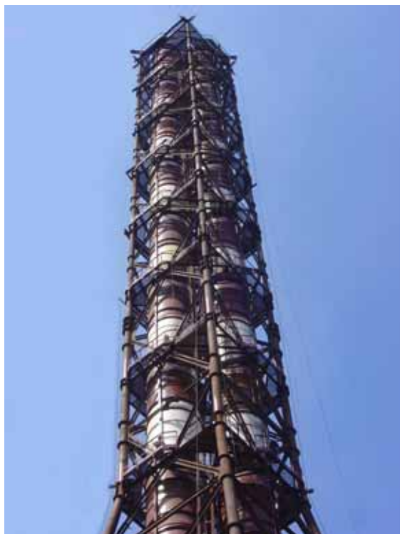
Фото № 4. Двухствольная труба из стеклопластика агломерационного цеха ОАО «ММК»
