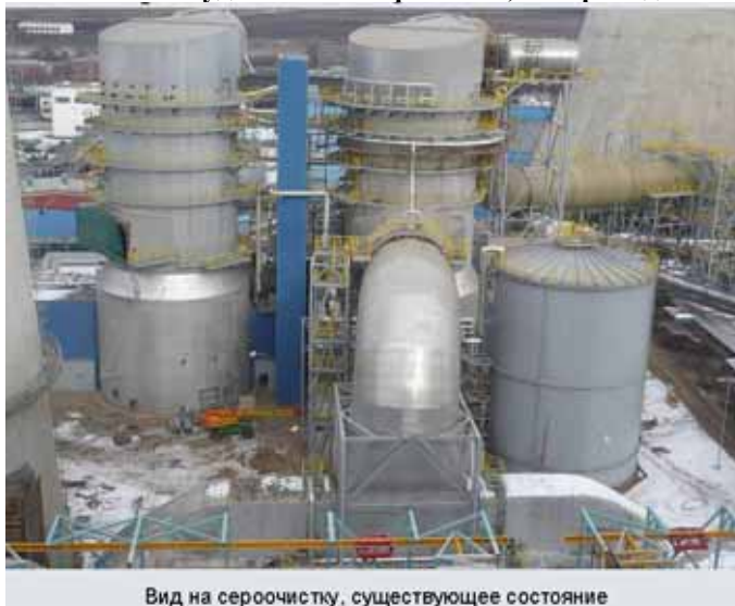
Вид на сероочистку, существующее состояние
