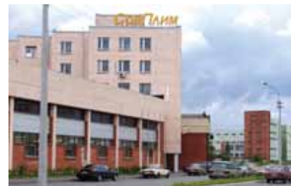
Рис. 1. Головной офис ЗАО «СовПлим» в г. Санкт-Петербурге.
