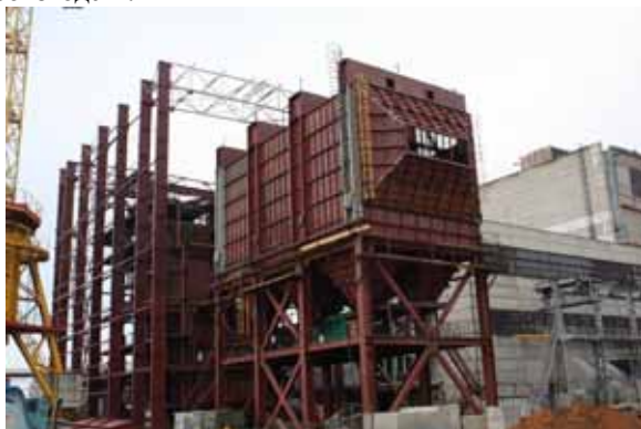
Монтаж электрофильтра «ФИНГО» на Жодинской ТЭЦ (Беларусь)
