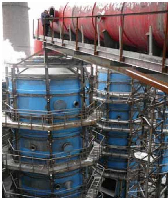
Фото №7. Монтаж подводящего газохода из стеклопластика к скрубберам. в агломерационном цехе ОАО «ММК»
