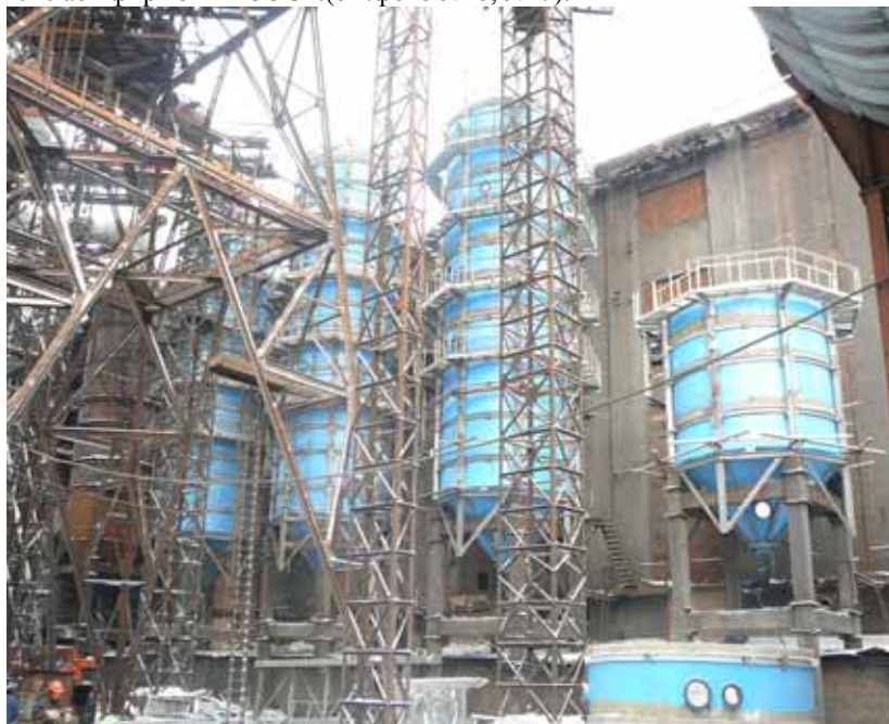
Фото №6. Монтаж скрубберов из стеклопластика в агломерационном цехе ГОП ОАО «ММК»
