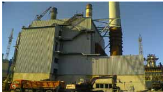
Рукавный фильтр ФРИ-2900 в ОАО «Новолипецкий металлургический комбинат».
