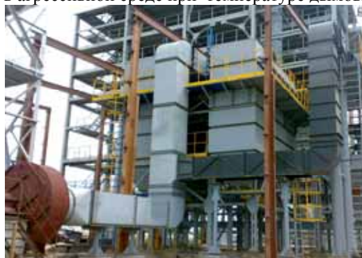
Рис. №2 Монтаж секционного фильтра, типа ФРИ-С(ОС).
