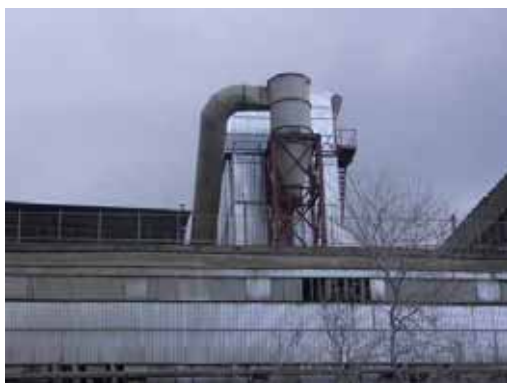
Новейшие разработки рукавных фильтров ФИНГО - ФРИ2000 и ФРИ 3400 - для газоочистки в цементной промышленности (фотографии фильтров в ОАО «Новоросцемент» и ОАО «Атакайцемент»)
