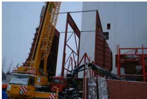
Установка электрофильтров в Финляндии
