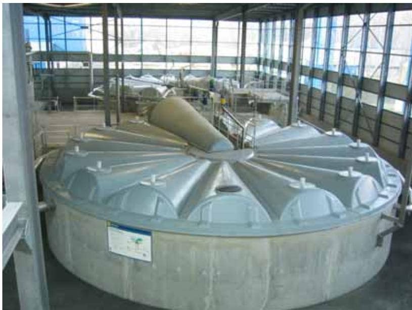
Megacell - MCH - горизонтальные ламельные флотаторы прямоугольной формы выпускаются с производительностью от 4м<sup>3</sup>/час до 800м<sup>3</sup>/час. Эти флотаторы могут работать на очень высоких исходных концентрациях взвешенных веществ до 14 000мг/л.
