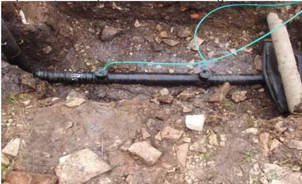
Рис. 4. МЭСТ, установленный на нефтепроводе ГЗУ 7В<sub>1</sub> НГДУ «Джалильнефть»
