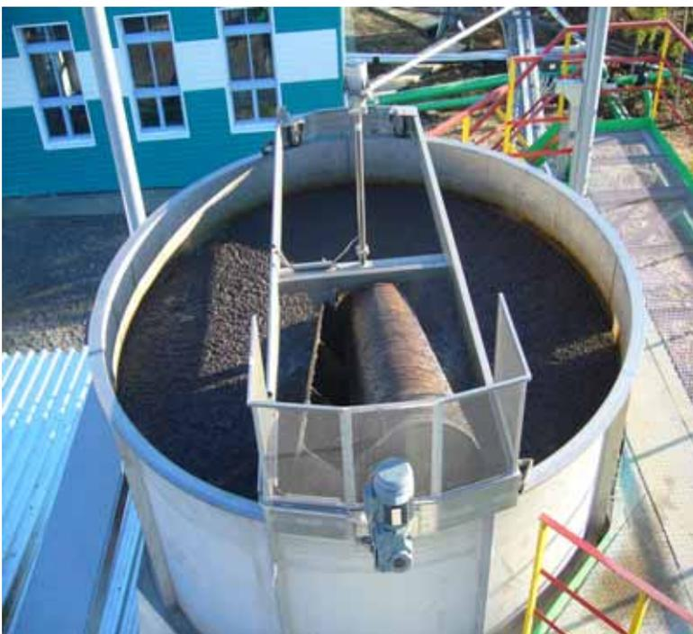
**2 этап.** Стоки после первого флотатора с расходом до 600м<sup>3</sup>/час поступают на флотатор. Сл 39, Сл 40.
