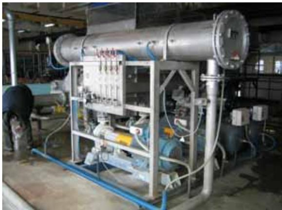
Основной принцип работы **ADR** - это гидродинамическое растворение воды в воздухе или газе, при котором вода подается в установку через специальную диспергирующую пластину, омываемую потоком жидкости с очень большой скоростью. В результате чего в системе происходит мгновенное поглощение газа жидкостью. Соответственно этот газ практически полностью растворяется в жидкости. В установках за 8-9 секунд пребывания достигается растворение воздуха 95-98% от равновесного. Сл 5.
