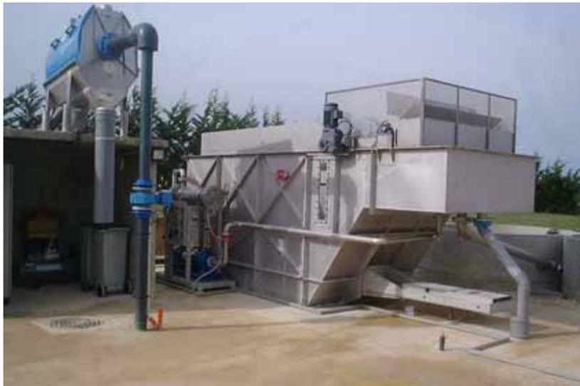
Klaricell - KLC – флотофильтры для водоподготовки питьевой или технологической воды и доочистки стоков. Сл 26.
