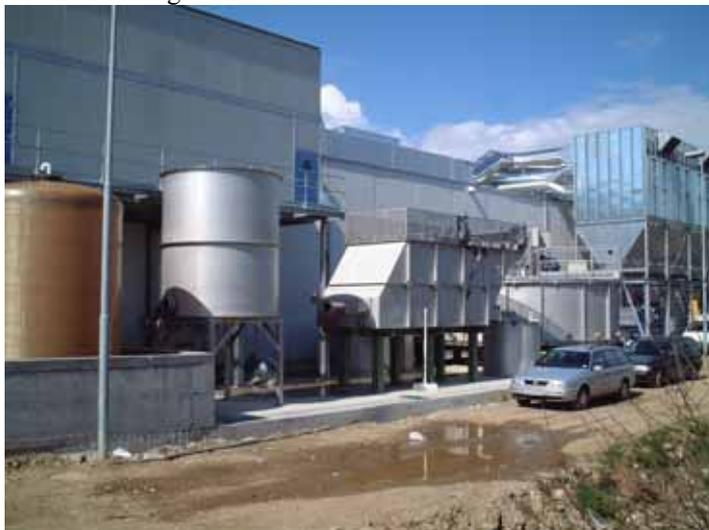
Megacell - MCV - вертикальные ламельные флотаторы башенного типа, прямоугольной или цилиндрической формы выпускаются с производительностью от 80м<sup>3</sup>/час до 1000м<sup>3</sup>/час. Эти флотаторы могут давать концентрации флотошлама до 120г/л (12%). Занимают эти флотаторы площадь 8,5 и 19м<sup>2</sup> соответственно. Выпускаются в герметичном взрывозащищенном исполнении, могут работать на воздухе, метане, азоте, углекислом газе и т.д.
