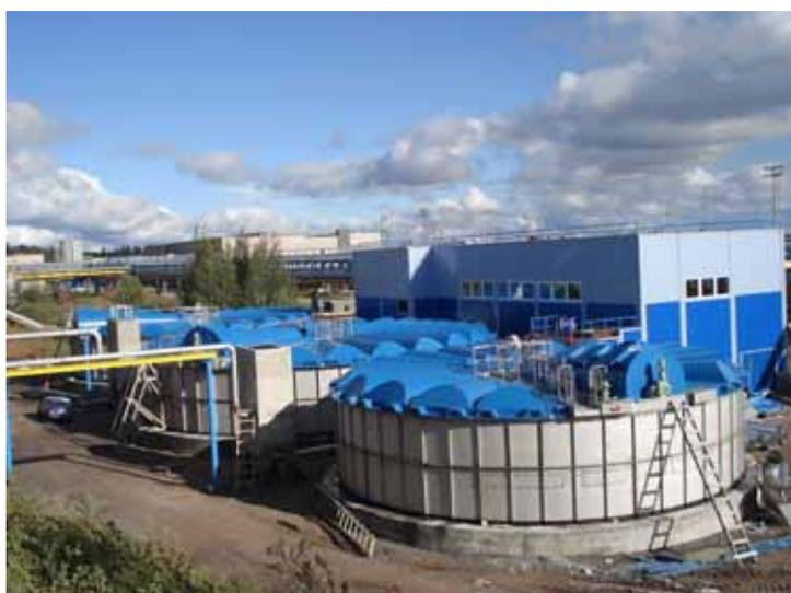
Технология «ОРБ» Сл 44, Сл 45. (однорезервуарные биореакторы) Эта технология использует только одну емкость для проведения всех стадий очистки стоков.
