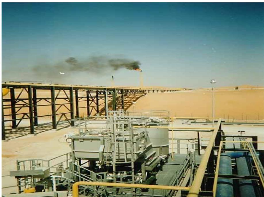
Г) «Хабаровский НПЗ» реконструкция очистных сооружений замена старых флотаторов на современные.
