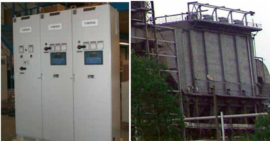
Трансформатор управляется микроконтроллером **Micro Kraft**, встроенном в **Шкаф управления питанием электрофильтра** .
