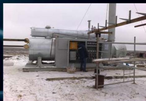
**Оборудование, выполненное на базе комплекса ДЕКОНТ-ЕХ, позволяет осуществлять обмен информацией с АСУ ТП верхнего уровня, используя различные каналы связи - радиоканал, GSM, передача данных по силовому кабелю, интерфейс RS-485 и др.**
