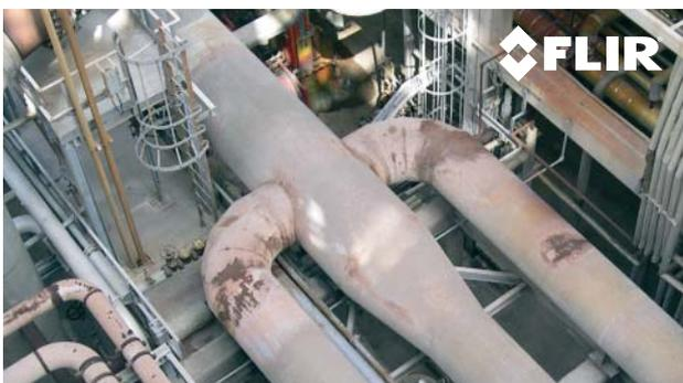
Рис. 4. Дефектный участок огнеупорной футеровки воздухопровода
