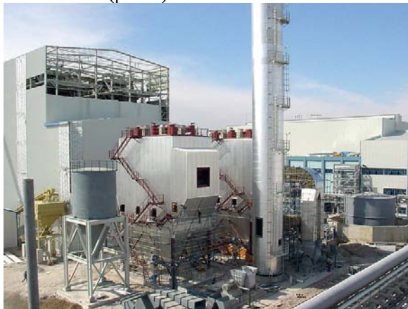
Рис. 2. Электрофильтр на заводе Samsat, Турция
