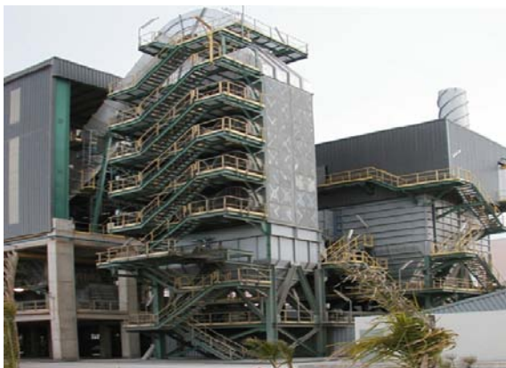
Рис. 5. Пример воздухо-воздушного теплообменника производства Redecam для цементного завода
