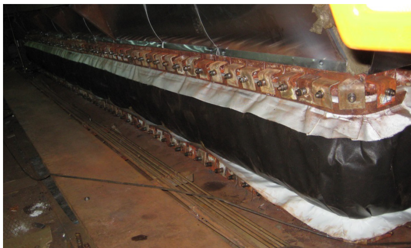
Рис. 1. Компенсатор конвективной шахты котла
