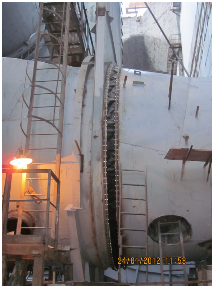
Рис. 4. Смонтированный компенсатор
