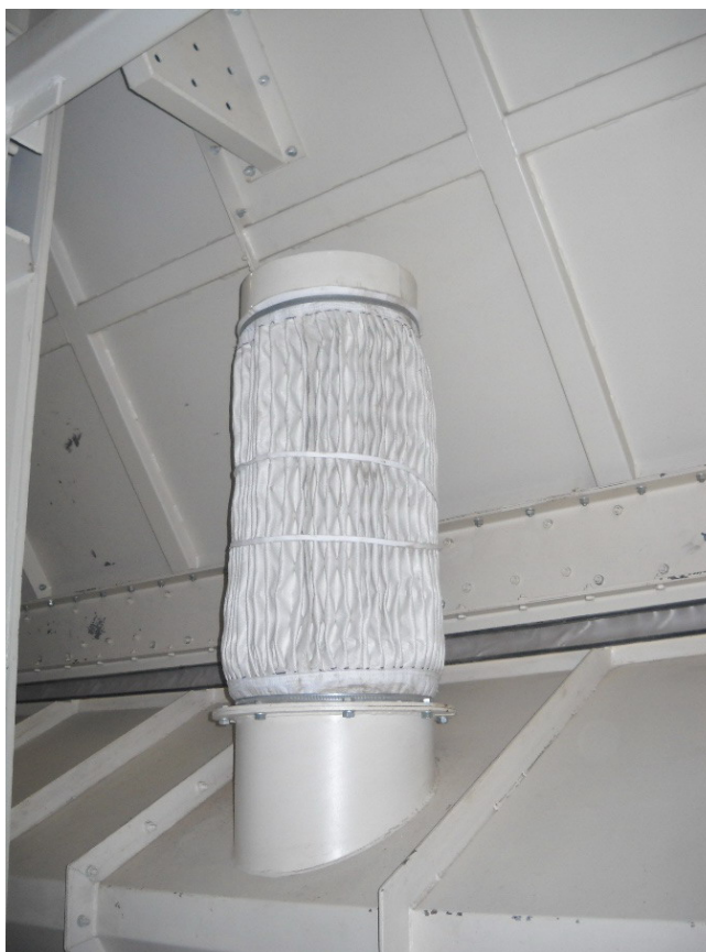
Рис. 6. ZDESA-фильтрпатрон с подачей запыленного воздуха внутрь.
