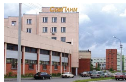
Рис. 1. Головной офис ЗАО «СовПлим» в г. Санкт-Петербурге.
