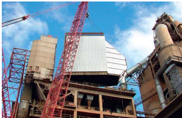
Рис. 3. Подъем двух секций электрофильтра
