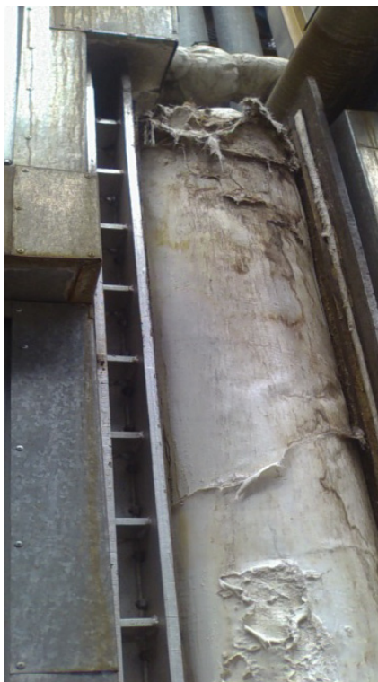
Рис. 2. Тканевый компенсатор с применением газоплотных слоев на основе силикона
