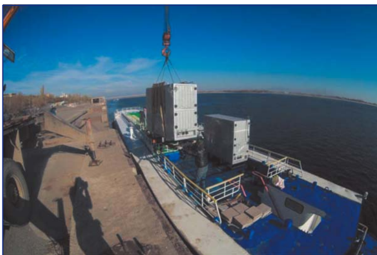
Рис. 3. Погрузка быстросъемных криогенных модулей со сжиженным природным газом СПГ на теплоход "Нева-6"
