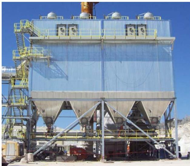
Рис.2. Однопоточный фильтр GEA ECOpuls
