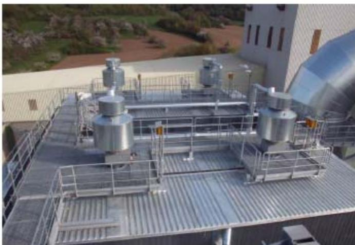
Рис.5. Резервуар сжатого воздуха со встроенными мембранными клапанами
