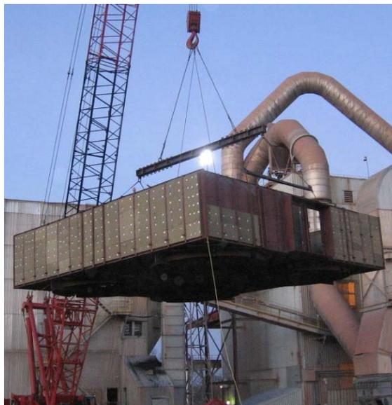
Рис.9. Установка камеры чистого газа
