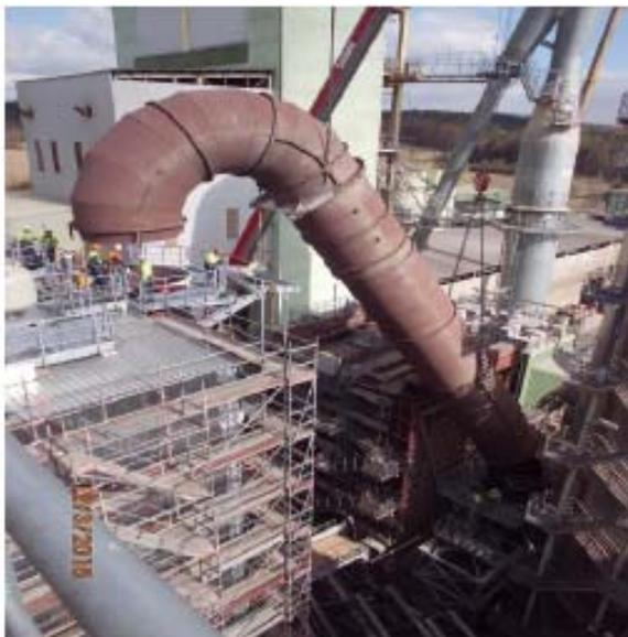
Рис.7. Монтаж газохода
