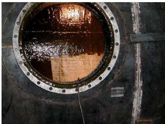
Защита цистерны под соляную кислоту
