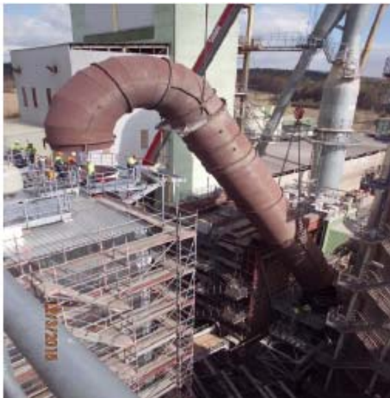
Рис.7. Монтаж газохода
