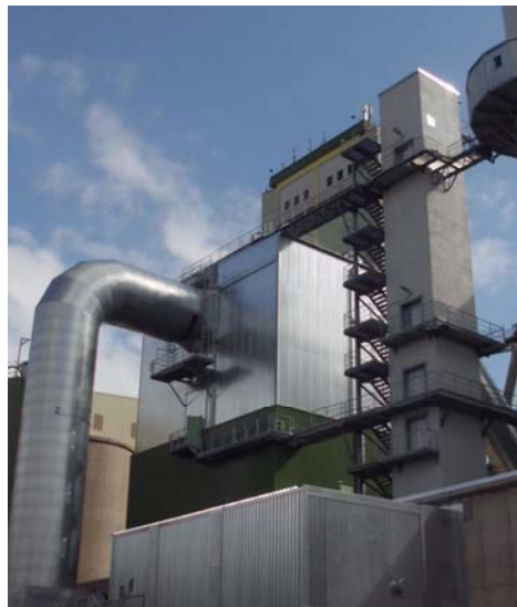
Рис.3. Двухпоточный фильтр GEA ECOpuls
