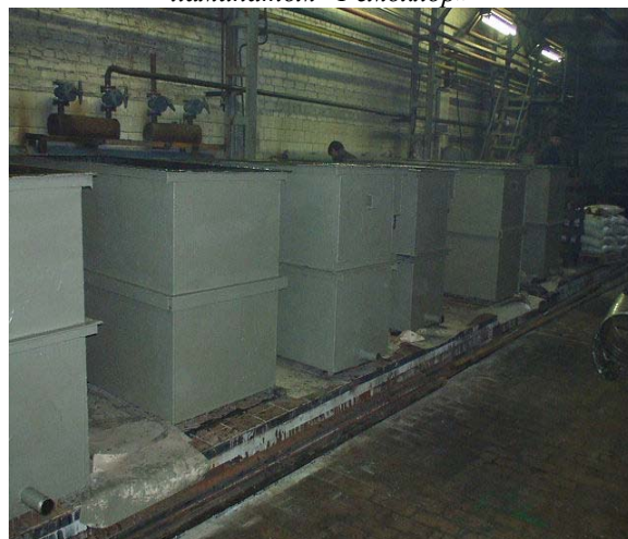
Гальванический цех защищенный ламинатами «Ремохлор»
