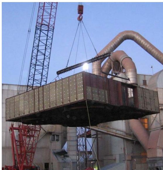
Рис.9. Установка камеры чистого газа
