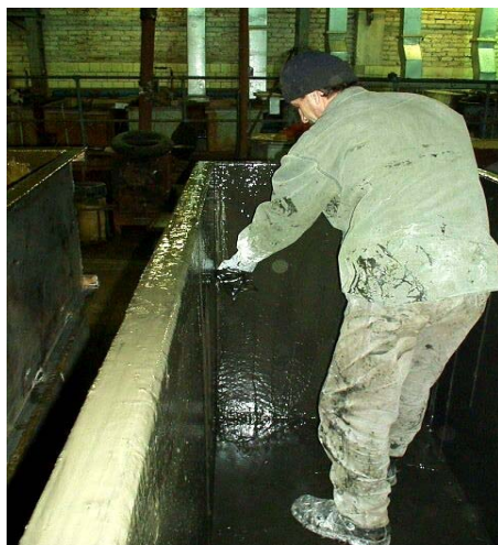
Защита гальванической ванны ламинатом «Ремохлор»
