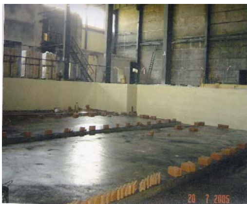
Поддоны под ванну травления, защищенные ламинатом «Ремохлор»
