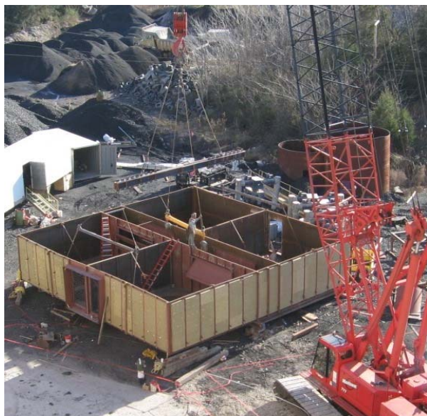
Рис.8. Сборка камеры чистого газа
